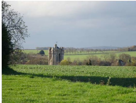
La vue remarquable sur le clocher de l'église depuis le plateau agricole
