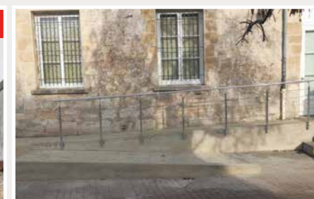
APRÈS | Rampe PMR, Âge d'Or
