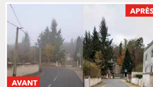
AVANT | Enfouissement des réseaux électriques
