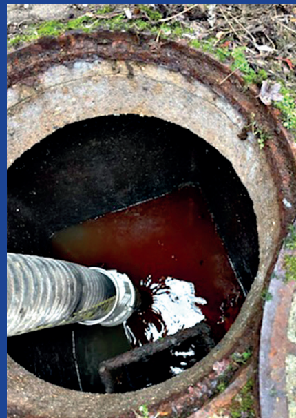
Sur place, l'entreprise SANET BUTIN, prestataire de curage du SIARP, a pu pomper environ 11 m 3 d'hydrocarbure
